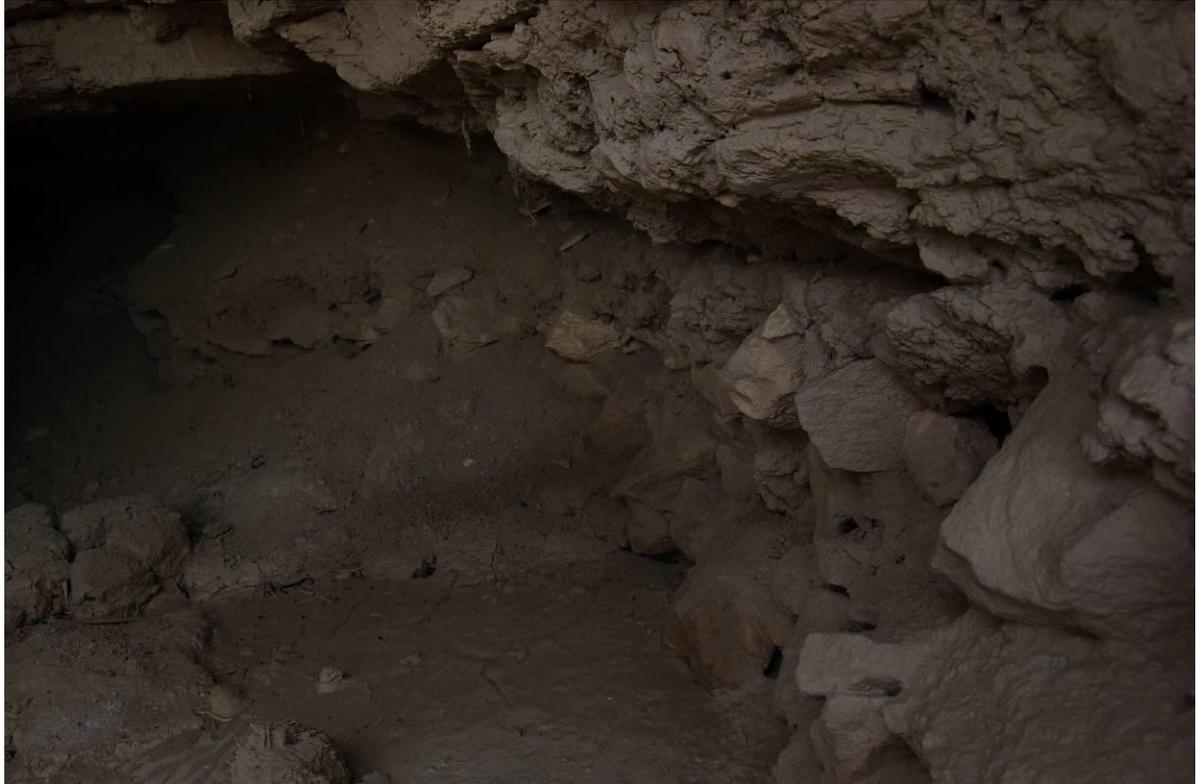
**Рис. 5.** Фундамент из рваного камня на глинистом растворе. Здание на «центральной» вершине.
